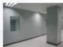
机房墙面处理
